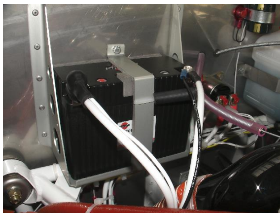
Obrázek 11-1 Baterie instalovaná na požární přepážce
